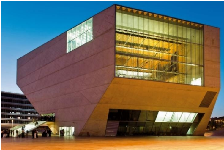
Casa da Música, Avenida da Boavista, Porto
